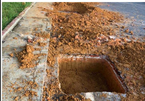
Foto 3 - Escavação dos blocos de fundação
