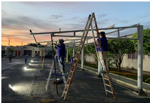
Foto 8 - Montagem e pintura de pilares, tesouras e terças.
