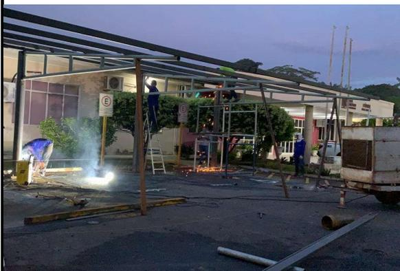
Foto 9 - Montagem de pilares, tesouras e terças.
