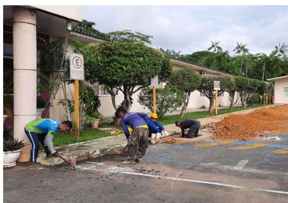
Foto 4 - Escavação dos blocos de fundação.
