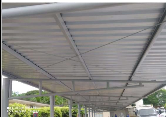
Foto 13 - Detalhe do contraventamento em "x" instalado.
