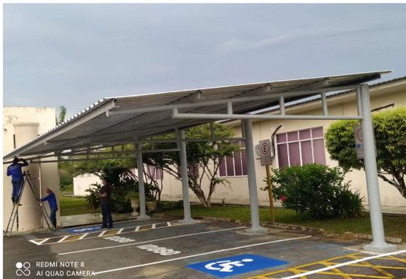
Foto 10 - Pintura dos pilares, tesouras e terças.
