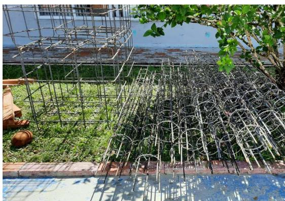
Foto 6 - Detalhes das armações dos blocos e estacas
