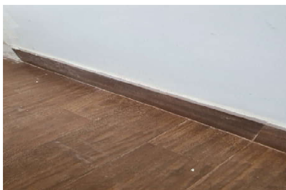
Foto 17 - Recolocação dos rodapés removidos.
