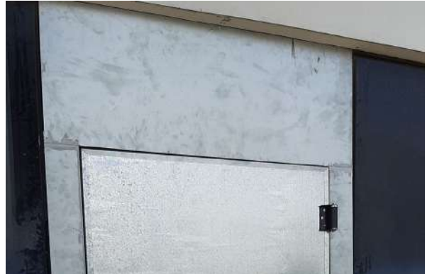
Foto 10 - Instalação das bandeiras.
