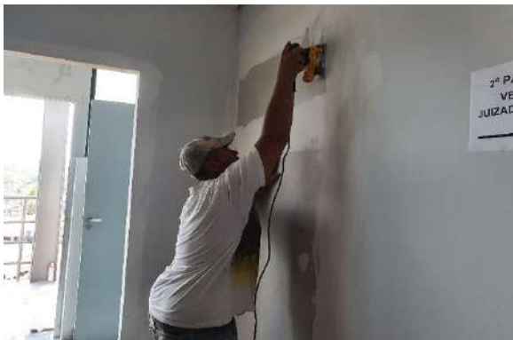
Foto 21 - Lixamento das paredes em drywall.
