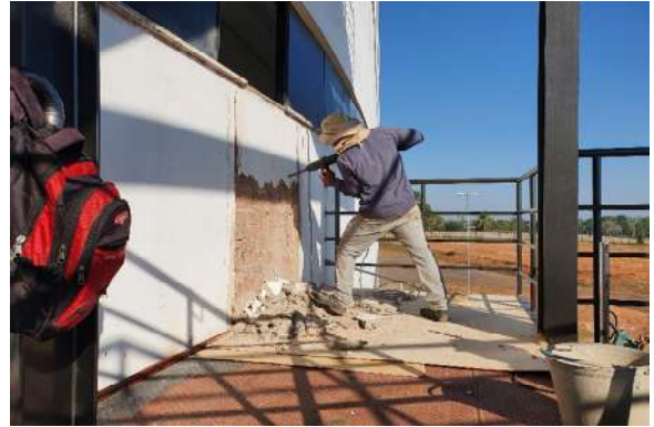
Foto 8 - demolição de parede de alvenaria para abertura do vão da porta corta fogo.
