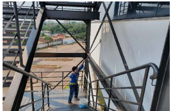
Foto 22 - Pintura das paredes externas.
