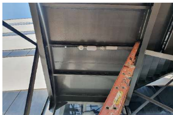
Foto 16 - Instalação dos sensores, luminárias e luminárias de emergência.
