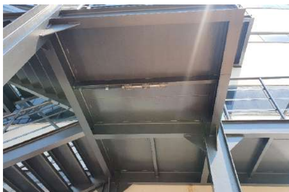
Foto 15 - Instalação dos condutores das instalações elétricas.
