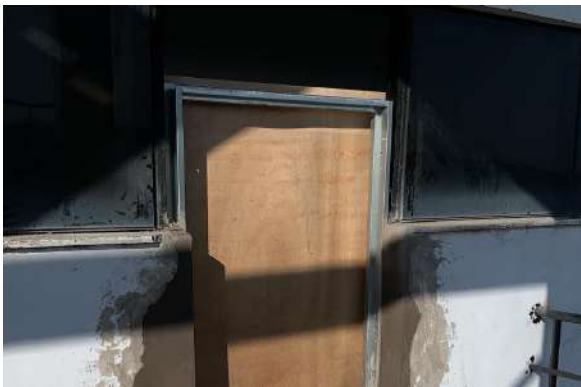
Foto 9 - Instalação dos batentes das portas corta fogo.
