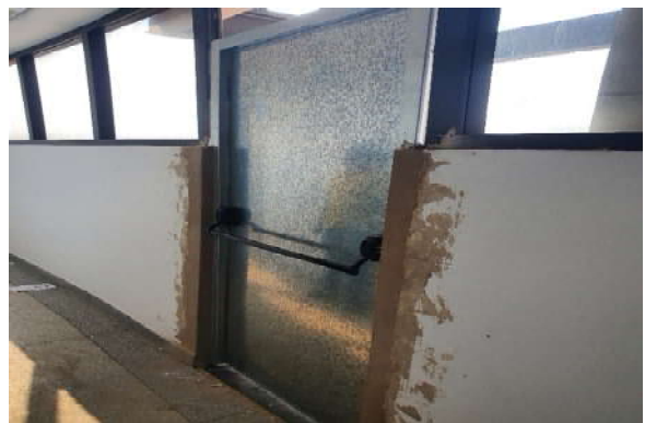
Foto 12 - Instalação das portas corta fogo, com barra antipânico.
