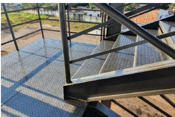
Foto 5 - Pintura dos patamares, degraus e guarda corpo da escada.
