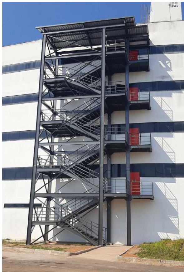
Foto 25 - Pintura geral, inst. elétricas e calçada de acesso concluídas.
