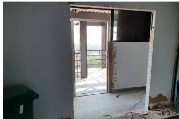
Foto 14 - Abertura de vão na parede de gesso.
