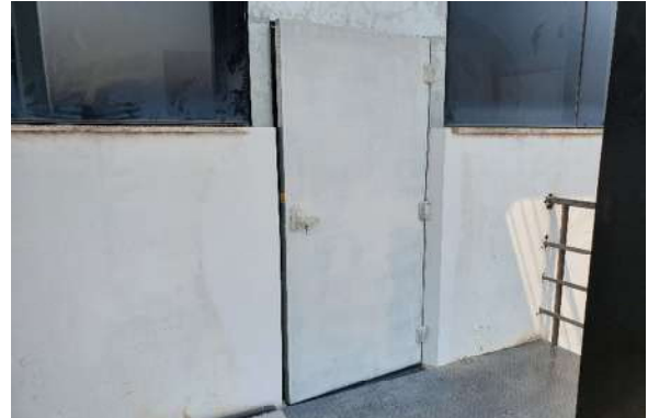
Foto 20 - Aplicação de galvite nas portas corta fogo.
