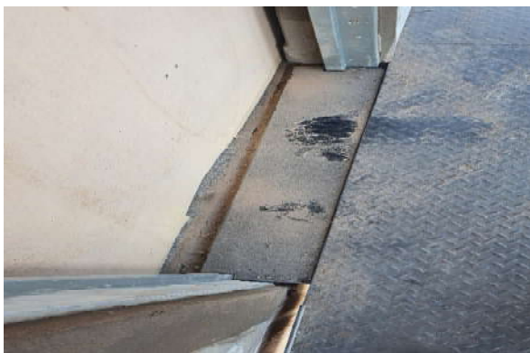
Foto 11 - Instalação das soleiras das portas.
