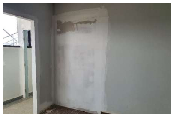
Foto 18 - Fechamento de aberturas com divisória em drywall.
