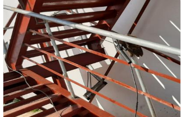
Foto 2 - Sequência de montagem do guarda-corpo com barra chata no lance de degraus.
