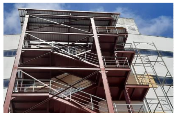
Foto 11 - Vista frontal da escada com o guarda-corpo instalado.
