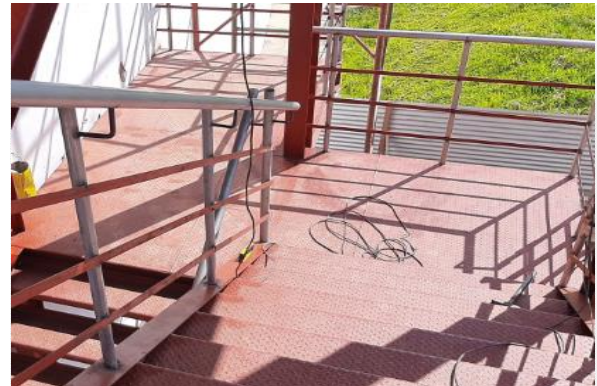
Foto 4 - Guarda-corpo e corrimão - patamar e lance de degraus.
