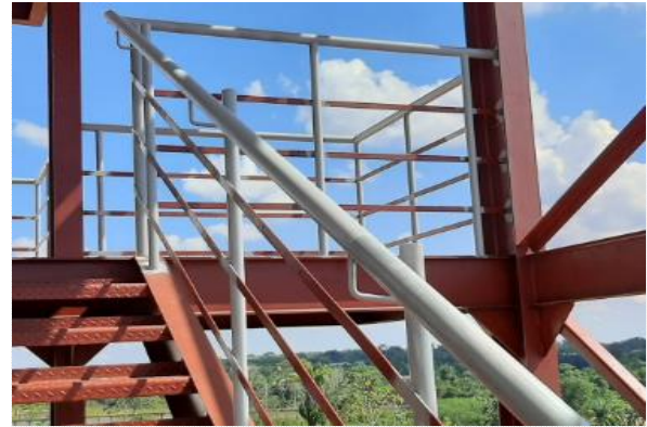
Foto 8 - Pintura anti-corrosiva no guarda-corpo.
