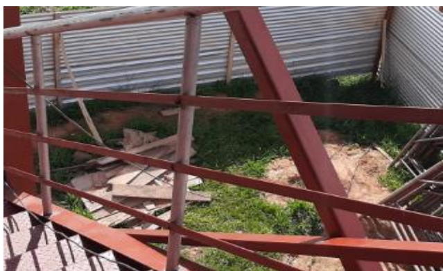
Foto 5 - Montagem do guarda-corpo - detalhe da fixação dos montantes.
