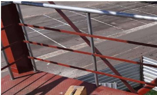
Foto 3 - Sequência de montagem do guarda-corpo com barra chata nos patamares.
