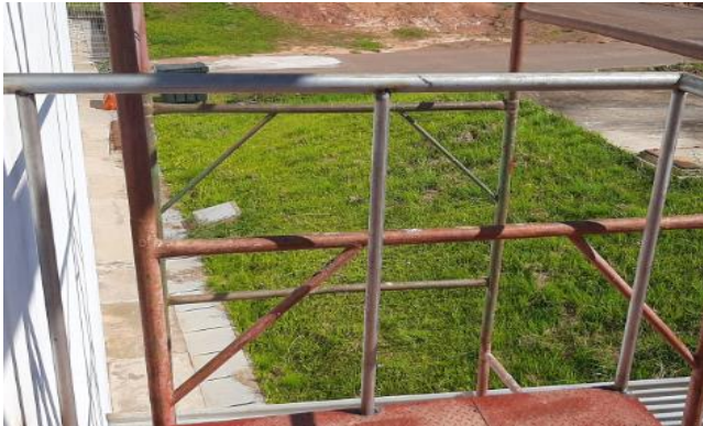
Foto 1 - Montagem do guarda-corpo nos patamares.
