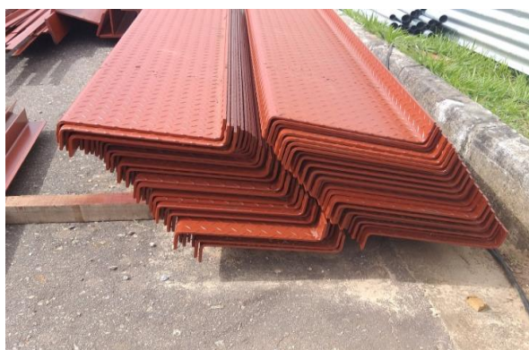
Foto 5 - Degraus em chapa de aço xadrez.
