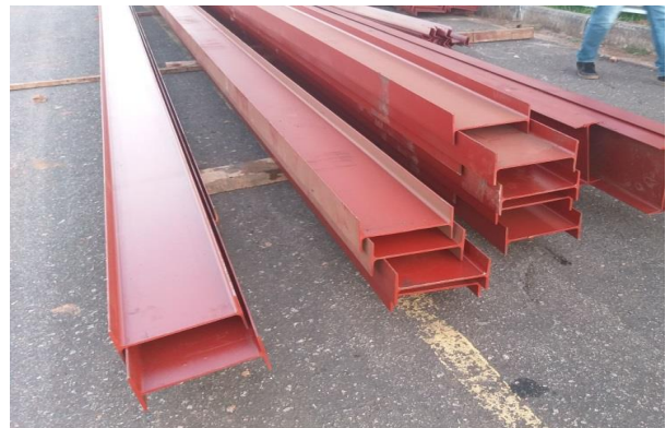
Foto 4 - Vigas metálicas W 250x17,9.
