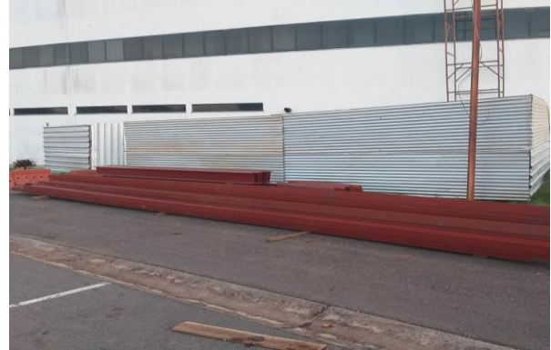
Foto 2 - Estrutura metálica entregue na obra.
