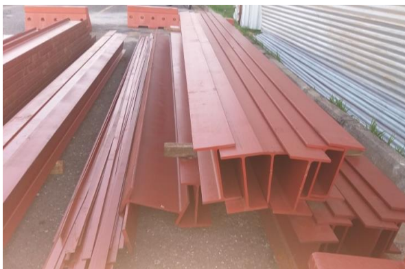
Foto 3 - Pilares metálicos W 250x44,8 no canteiro.
