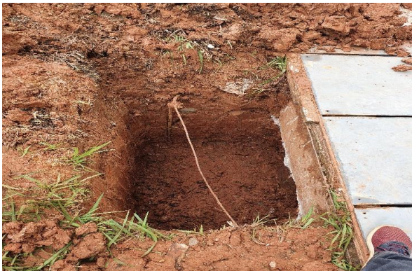
Foto 9 - escavação manual de sapatas.
