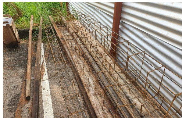
Foto 12 - Fabricação das armações das vigas baldrames.
