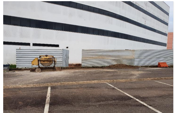
Foto 4 - Tapume de obra, com portão de acesso.
