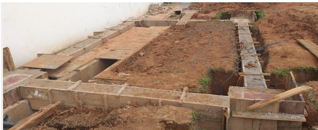
Foto 23 - Finalização da concretagem.
