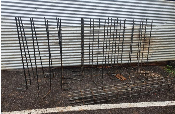
Foto 13 - Fabricação das armaduras dos fustes da fundação.
