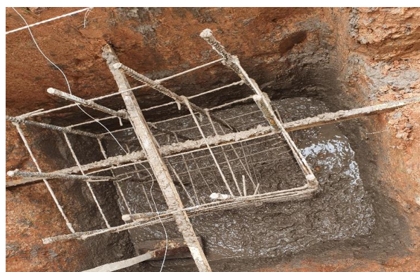
Foto 18 - Concretagem do fundo das sapatas.
