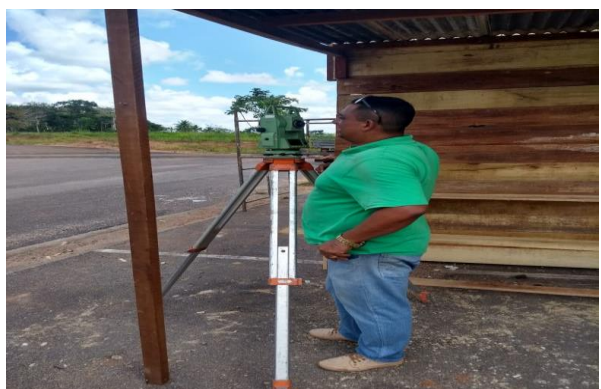
Foto 6 - locação topográfica da obra.
