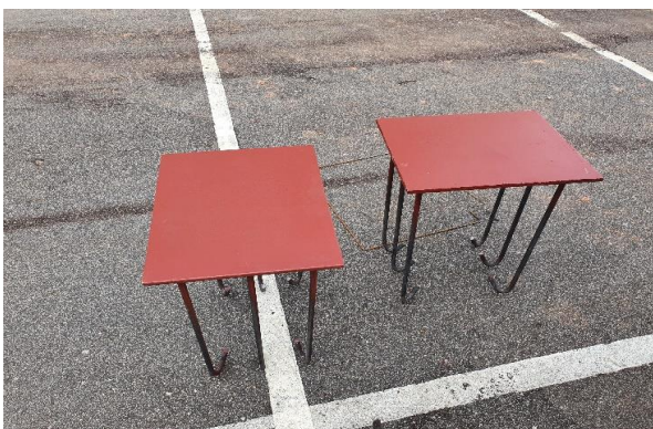
Foto 17 - Placa base da estrutura metálica com ganchos de ancoragem em J.
