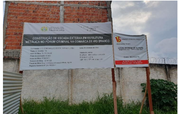
Foto 2 - Placa da obra.
