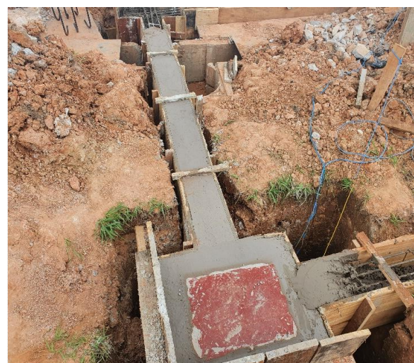
Foto 22 - Concretagem das vigas baldrame e sapatas.
