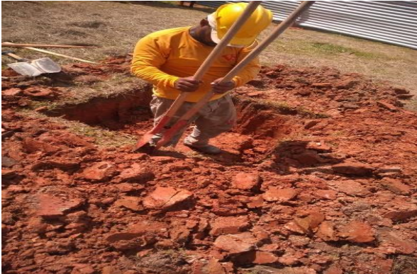
Foto 7 - Escavação manual de vala de sapata.
