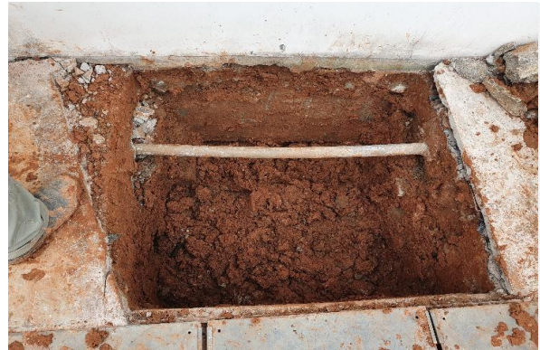
Foto 8 - Serviços de demolição de concreto e escavação de manual de vala para sapata.
