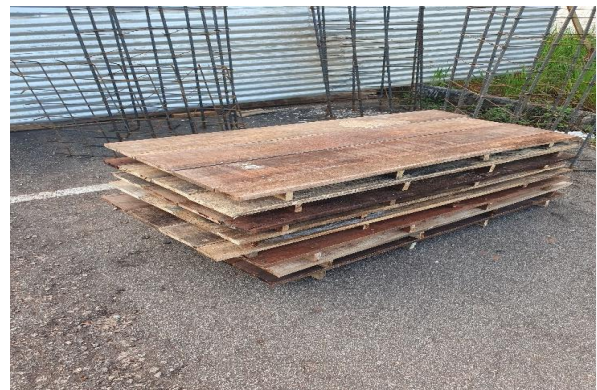
Foto 16 - Fabricação dos painéis das fôrmas de caixaria.
