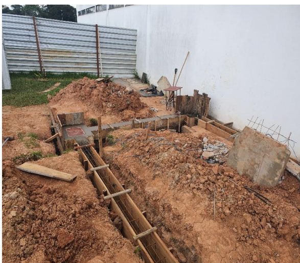
Foto 21 - Concretagem de vigas e sapatas.
