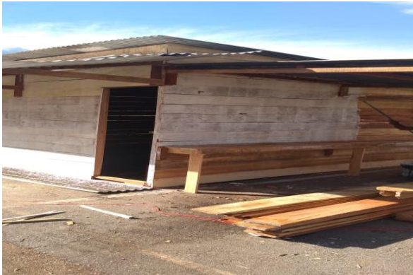
Foto 1 - Depósito do canteiro de obras.
