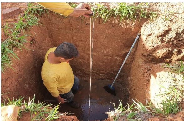
Foto 11 - Execução de lastro de concreto magro em fundo de vala.
