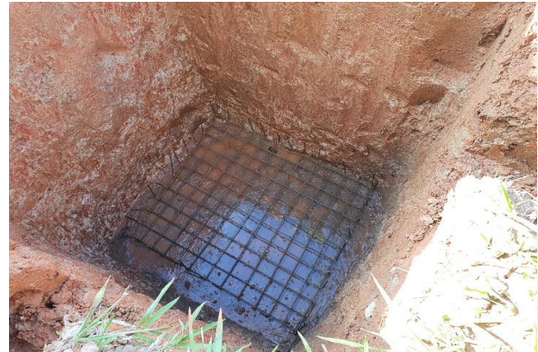
Foto 14 - Posicionamento da armação da sapata no fundo de vala.
