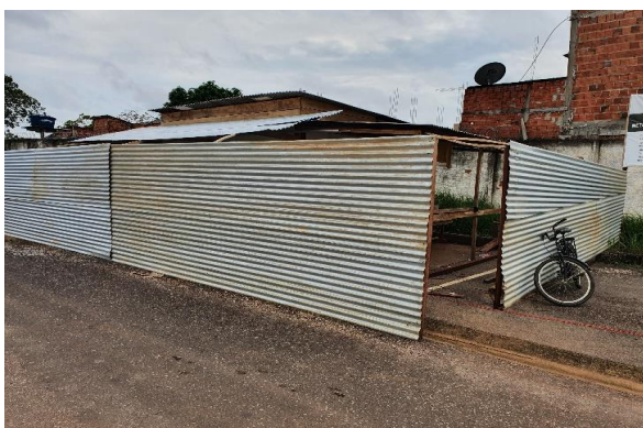
Foto 5 - Isolamento do canteiro de obras com tapume.
