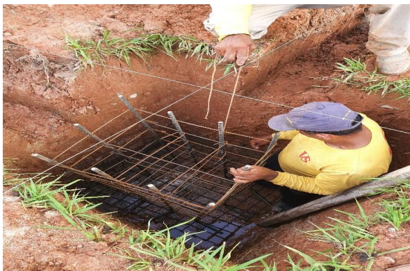
Foto 15 - Posicionamento da armação dos fustes.
