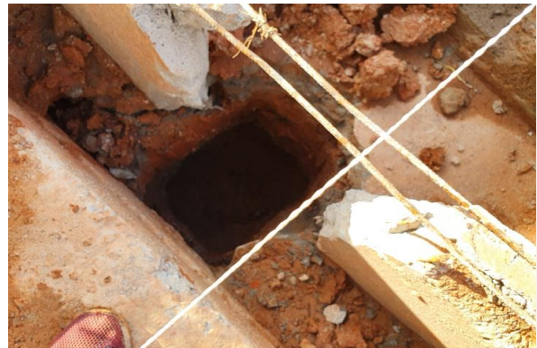
Foto 10 - Demolição de viga de concreto e escavação de vala para estaca broca.
