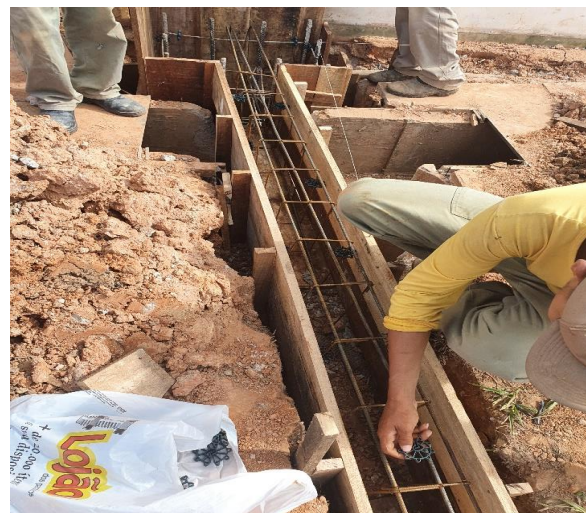
Foto 20 - Posicionamento de espaçadores de concreto nas vigas baldrame.
