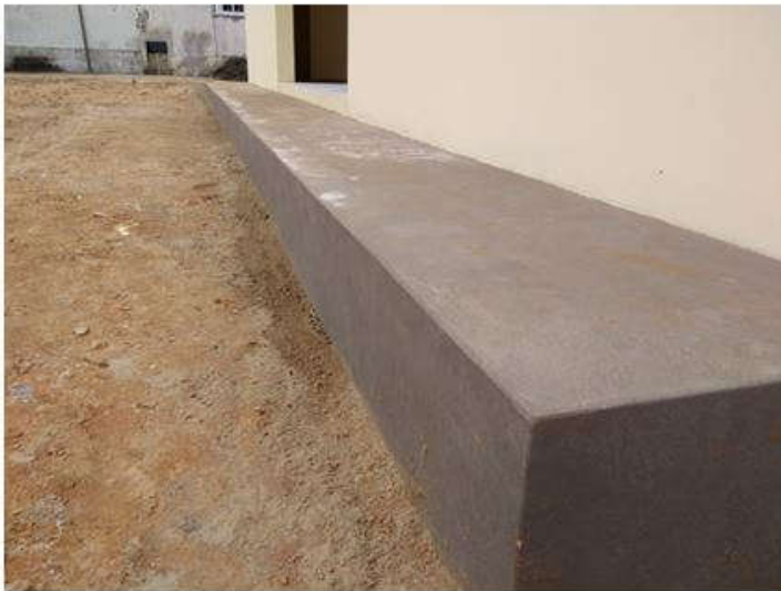
Foto3: calçada externa para acesso entre a cela e o prédio do Fórum.
