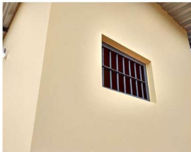
Foto6: grade do sanitário.
