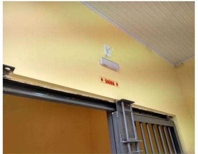
Foto4: iluminação de emergência instalada e sinalizada.
