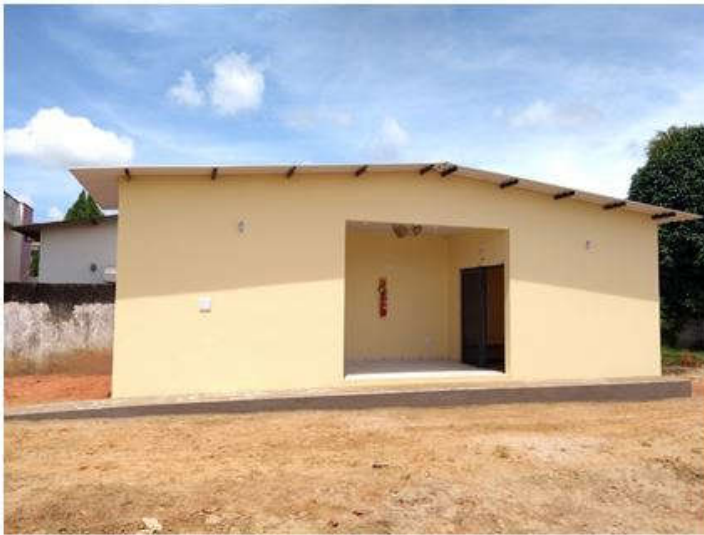
Foto1: vista da fachada frontal da cela, totalmente finalizada.
