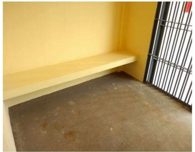
Foto10: interior da cela com piso cimentado e banco em concreto pintado.
