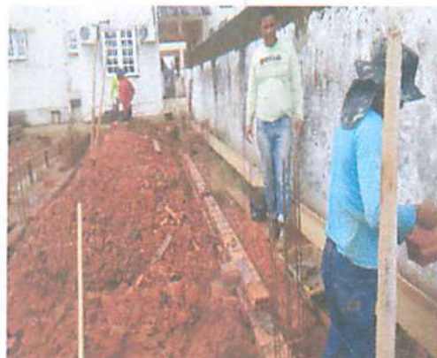
Foto 6 - Execução de alvenaria de embasamento
