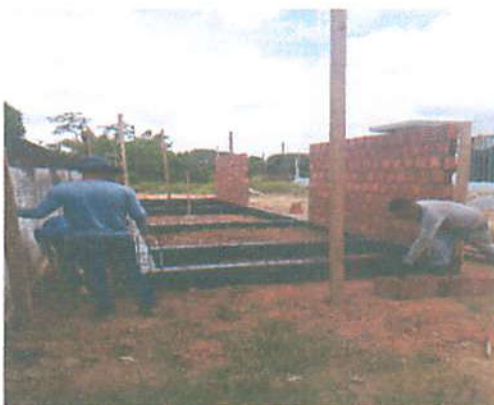
Foto 11 - Impermeabilização da fundação
