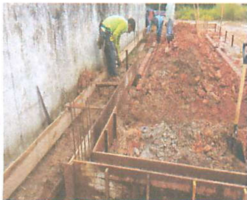
Foto 7 - Execução de fôrma para viga baldrame
