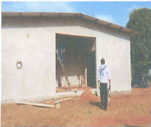
Foto 15 - Revestimento de parede concluído
