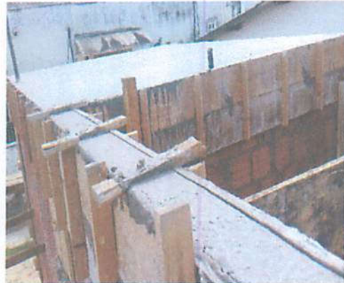
Foto 14 - Laje e vigas concretadas
