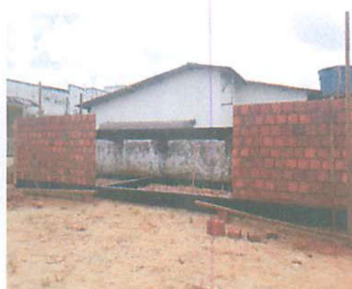
Foto 12 - Execução de alvenaria
