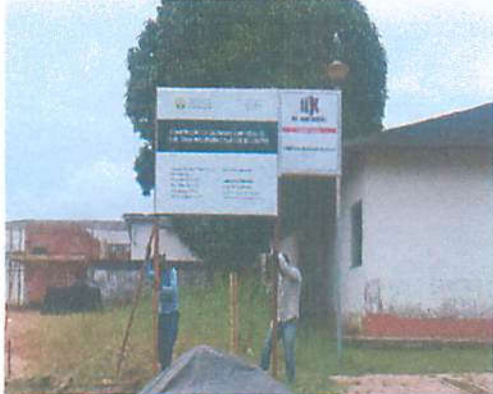
Foto 1 - Placa da Obra em Sena Madureira
