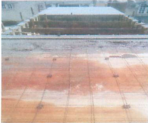
Foto 13 - Execução da laje
