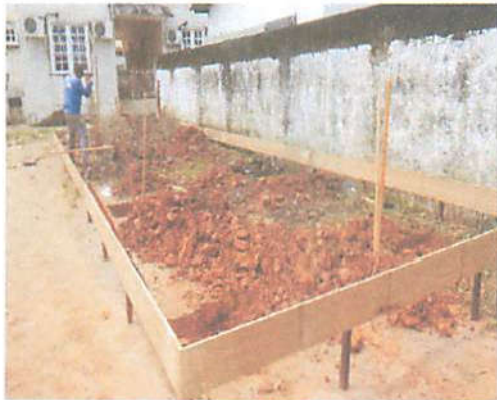
Foto 3 - Locação da Obra
