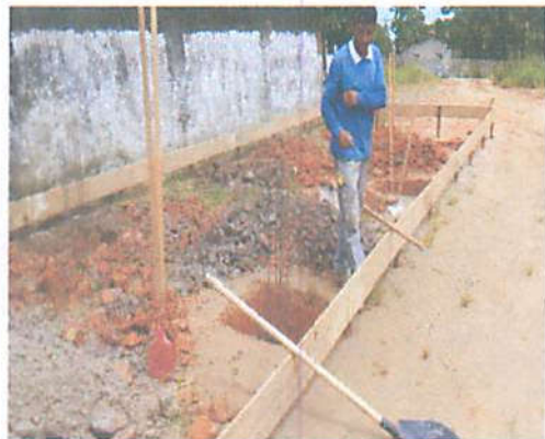
Foto 4 - Escavação de solo para execução da fundação
