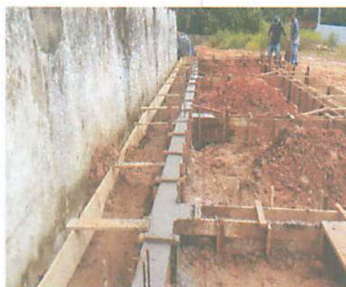
Foto 10 - Concretagem de viga baldrame
