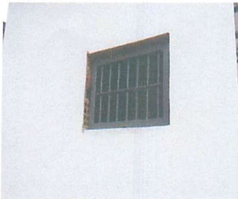
Foto 17 - Esquadria de aço concluída
