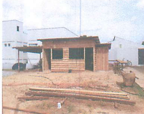
Foto 2 - Execução de escritório, depósito e sanitário no canteiro de obras
