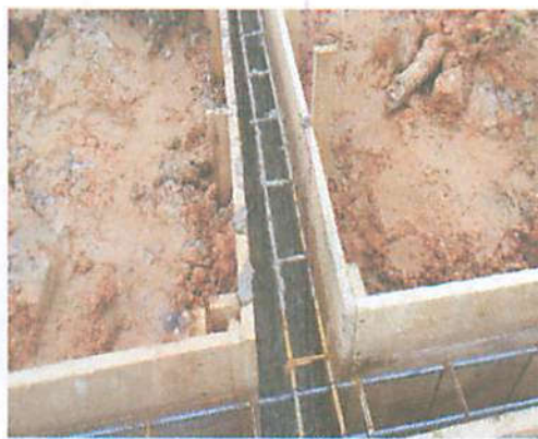
Foto 8 - Ferragem da viga baldrame
