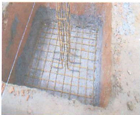
Foto 5 - Execução de fundação
