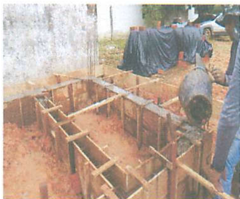
Foto 9 - Concretagem de viga baldrame
