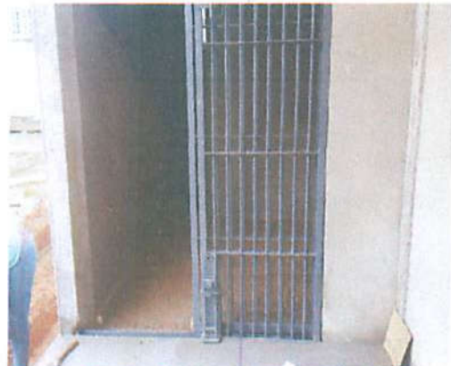
Foto 18 - Esquadria de aço concluída
