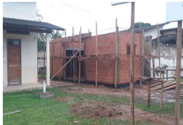
Foto 8 - Alvenaria em execução.
