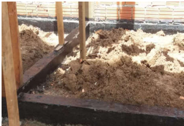
Foto 7 - Detalhe da impermeabilização.
