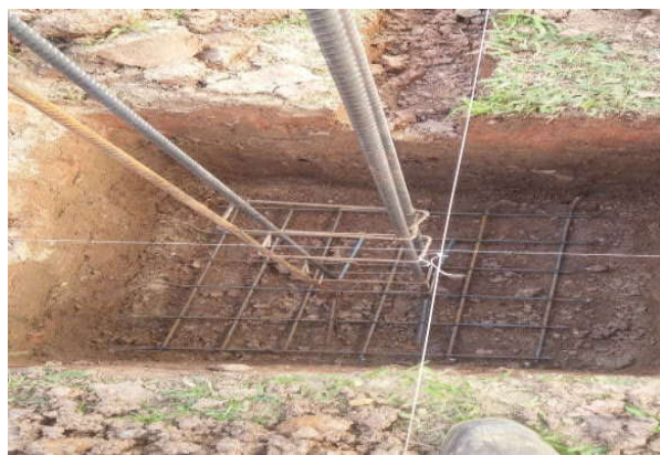
Foto 4 - Vala para fundação.
