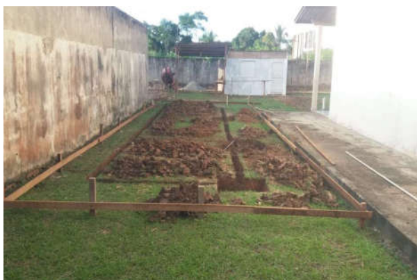
Foto 3 - Limpeza e locação da obra.
