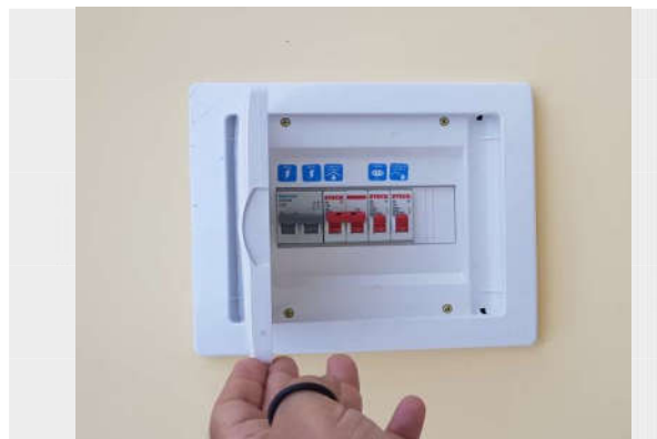
Foto 16 - Quadro Disjuntores.
