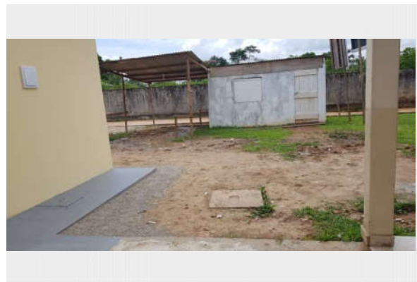
Foto 2 - Depósito executado pela empresa.
