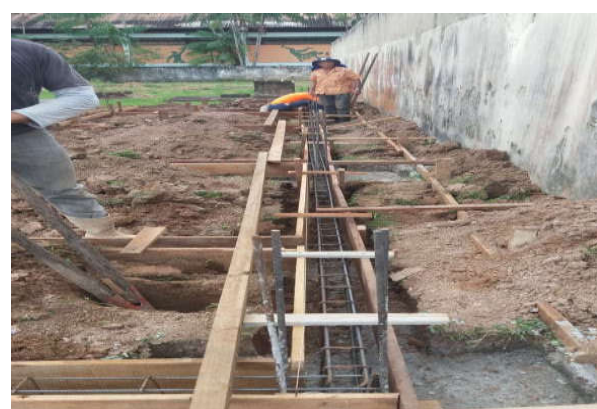
Foto 6 - Execução de viga baldrame.
