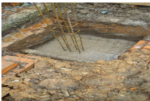
Foto 5 - Detalhe da fundação.
