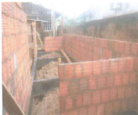
Foto 11 - Execução da alvenaria
