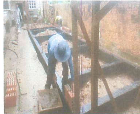
Foto 10 - Impermeabilização da fundação
