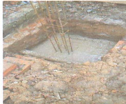
Foto 6 - Execução da fundação
