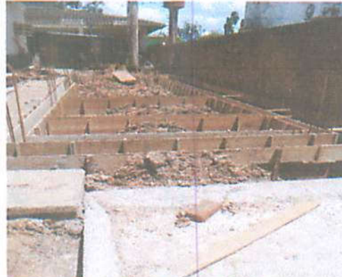
Foto 8 - Fôrma da viga baldrame
