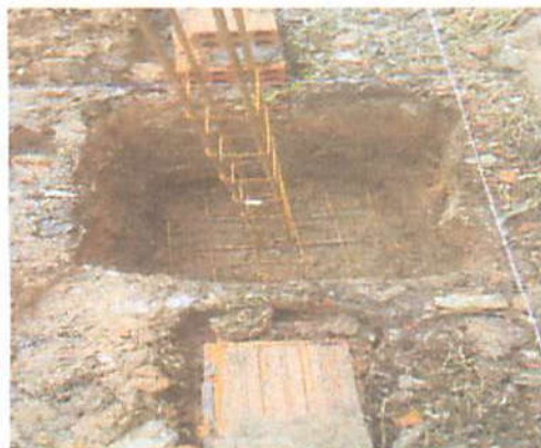
Foto 5 - Execução de vala para fundação
