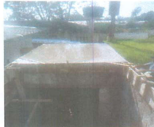
Foto 12 - Execução da laje
