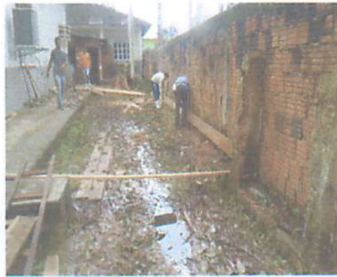
Foto 4 - Início da locação da obra
