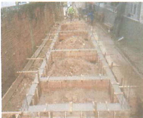
Foto 9 - Concretagem da viga baldrame
