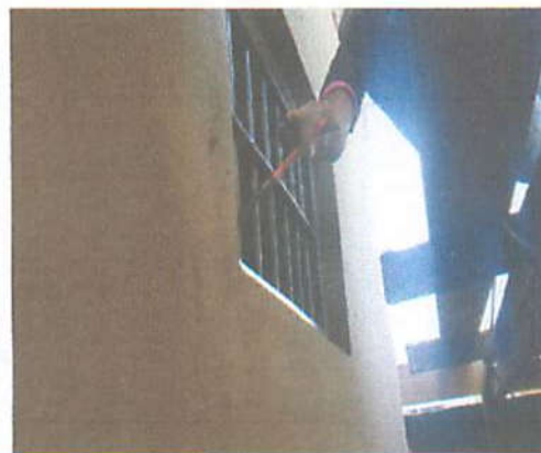
Foto 17 - Pintura da esquadria de aço
