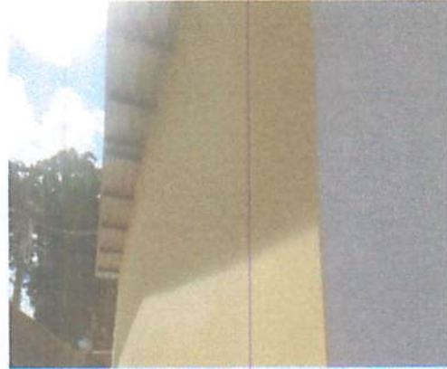
Foto 14 - Execução da pintura
