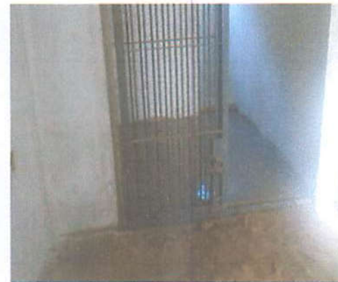
Foto 18 - Esquadria de aço concluída e execução de piso cimentado
