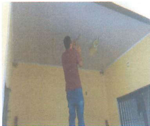
Foto 15 - Forro concluído e execução das instalações elétricas
