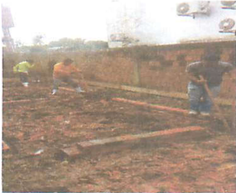
Foto 7 - Execução da alvenaria de embasamento
