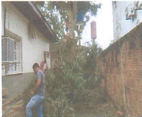
Foto 3 - Retirada de árvore para execução da obra
