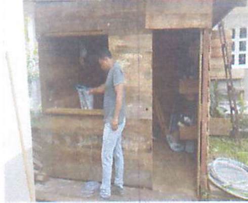
Foto 2 - Execução de depósito no canteiro de obras
