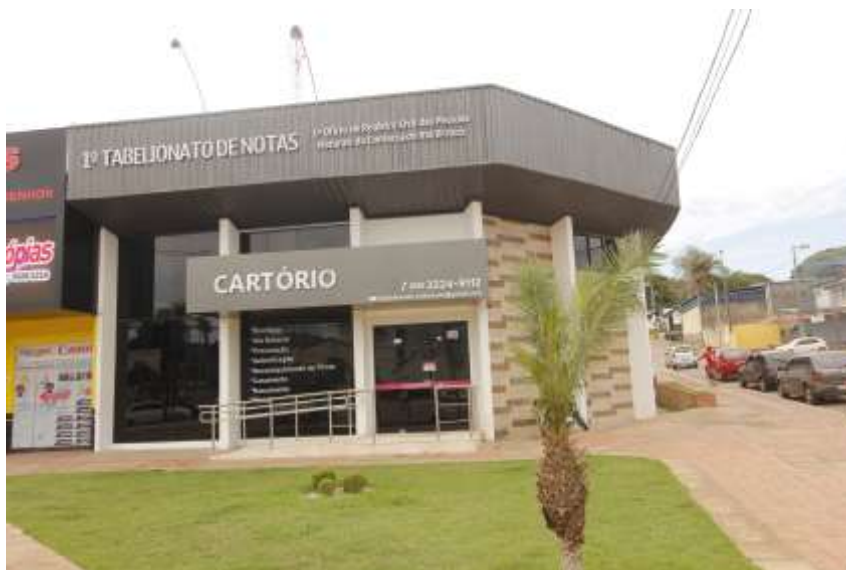
Fachada Principal da Serventia
