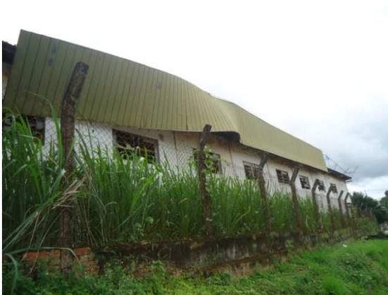
**Foto 03:** Vista lateral e platibanda.
