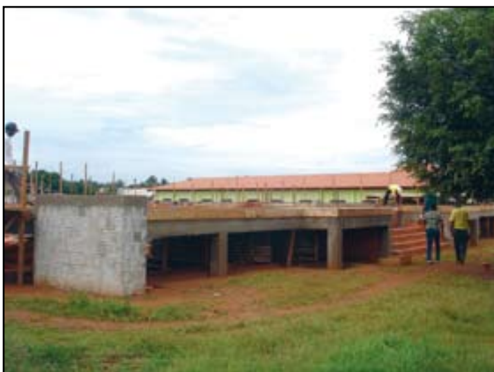
Iniciada a construção do novo Fórum de Capixaba
