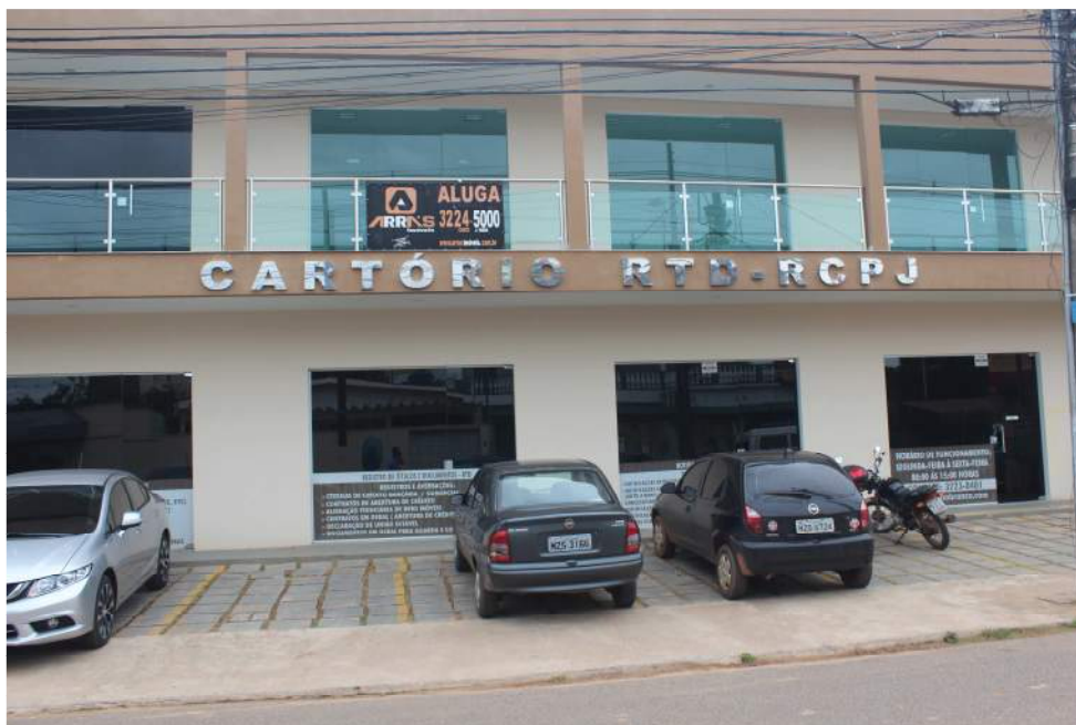
Fachada Principal da Serventia
