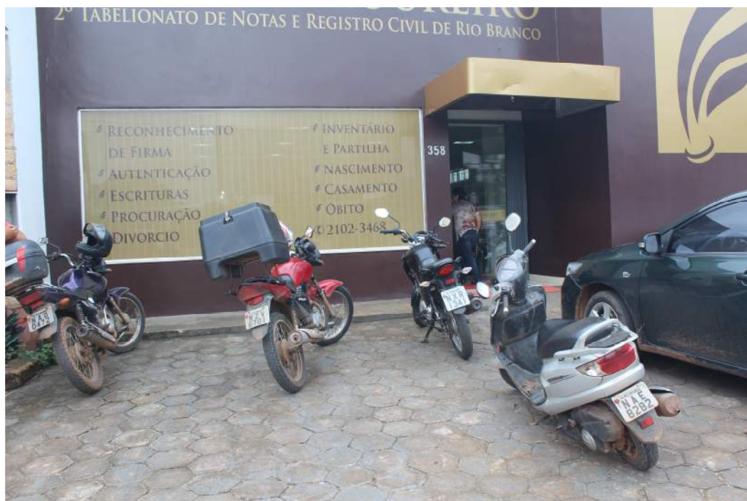
Foto 9 – Fachada principal da Serventia
